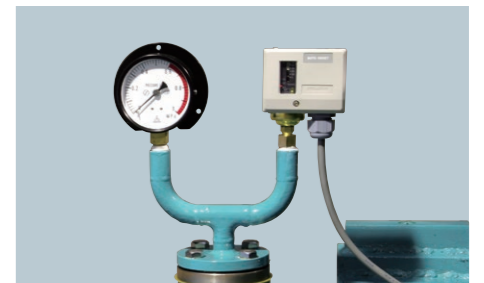
4 スラリーの打ち込み圧力を測定して、適正なケーキ厚みになるようタイマーで制御します。
