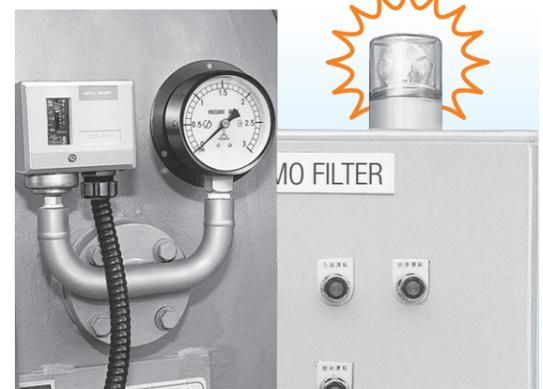
**3** 洗浄もボタンを押すだけで自動的に行われます。また特殊洗浄により円板ろ材は超強力に洗浄されます。(特許)※リングブローのオプションもあります。
